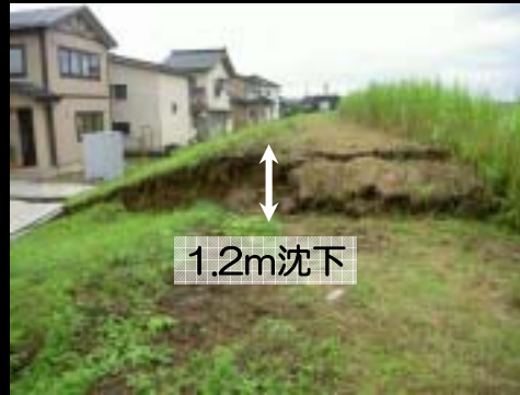
写真3 鯖石川現河道堤防の沈下（柏崎地域振興局提供）
