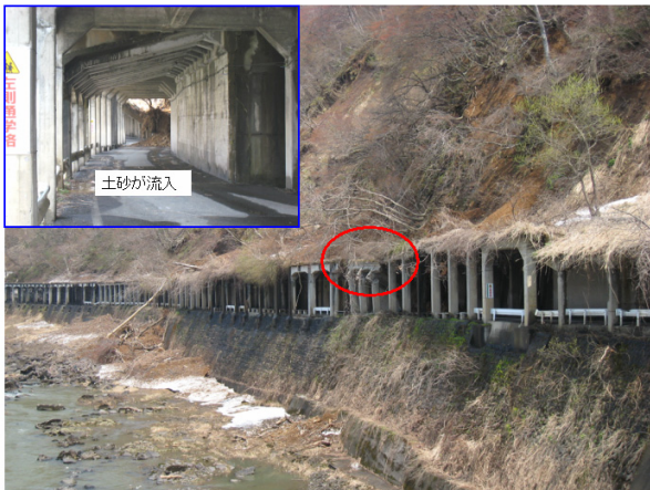
写真2.4-1 覆道の被害 (図2.4-1のNo. 1の箇所)
