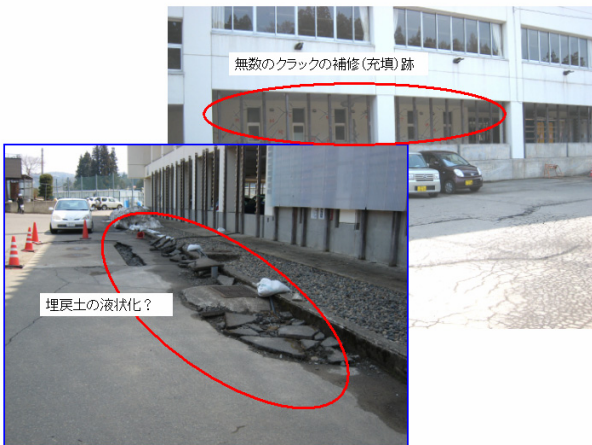
写真2.4-2 栄小学校の被害 (図2.4-1のNo. 2の箇所)
