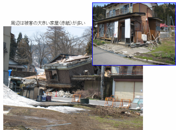
写真2.4-4 民家の被害 (図2.4-1のNo. 3の箇所)
