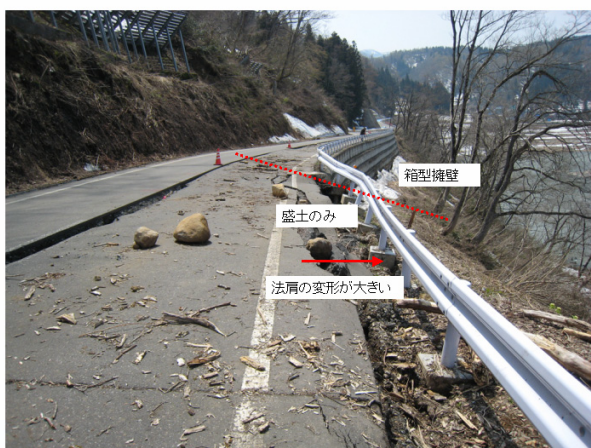
写真2.4-6 道路の被害 (図2.4-1のNo.4の箇所)
