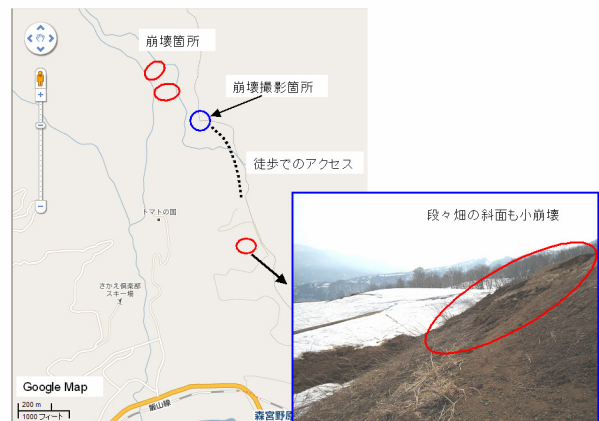
図2.6-2 崩壊箇所へのアクセス
