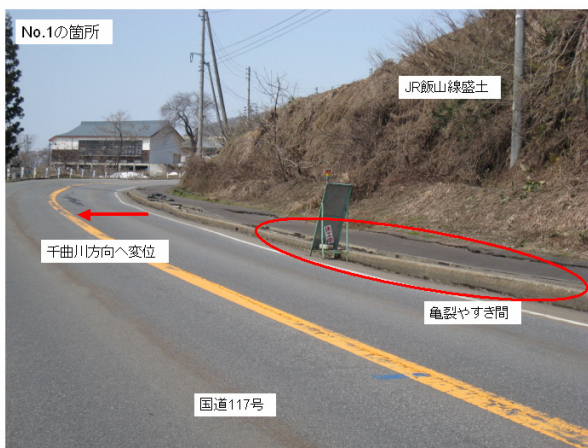
写真2. 3-1 国道117号の被害（図2. 3-1のNo. 1の箇所）
