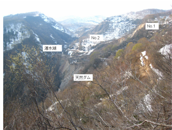
写真2.6-2 北信の斜面崩壊（全景）
