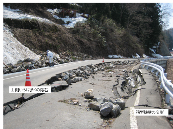
写真2.4-5 箱形擁壁の被害 (図2.4-1のNo. 4の箇所)
