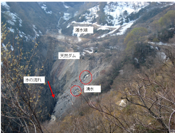
写真2. 6-4 北信の斜面崩壊（湛水湖下部）
