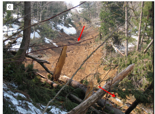
写真2.2-2 七ヶ巻の崩壊（図2.2-1のC地点）
