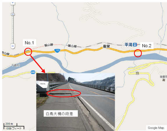
図2. 3-1 栄村豊栄の国道117号の被害箇所
