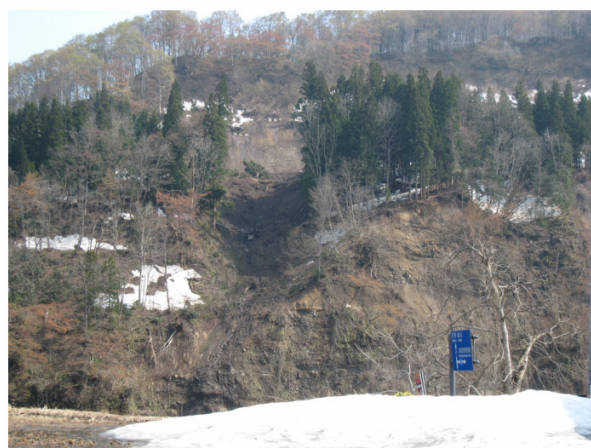
写真2.5-3 斜面の崩壊 (図2.4-1のNo.6の箇所)
