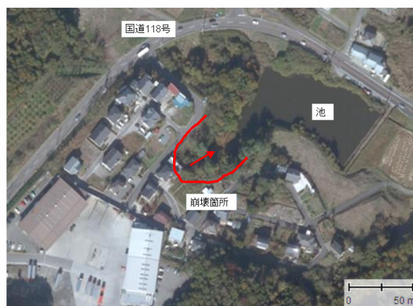
写真4.3-4 崩壊箇所（電子国土のオルソ画像（2009年度撮影）を利用）
