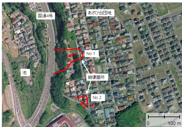
写真4.2-5 崩壊箇所（電子国土のオルソ画像（2007年度撮影）を利用）
