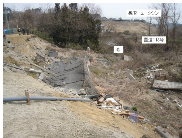
写真4.3-2 崩壊上部から下方向
