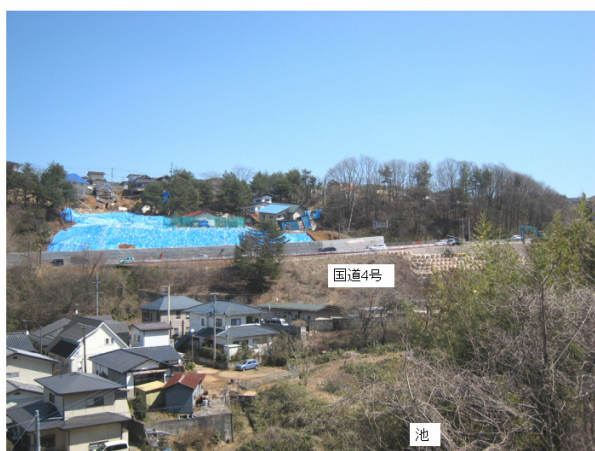
写真4.2-1 あさひ台団地の崩壊全景
