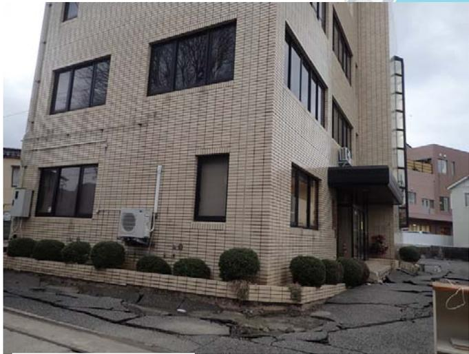
噴砂が局所的であること、国土地盤情報センターで公表されているボーリングデータより、原地盤の液状化ではなく、埋土等の液状化か？
