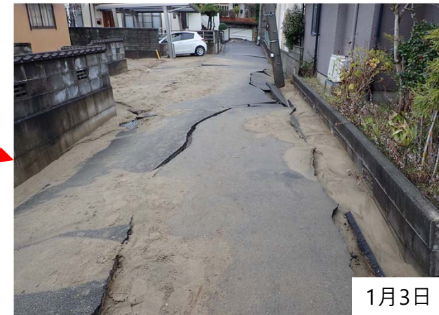
坂井輪中付近は甚大な液状化被害 県道沿いの歩道は隆起
