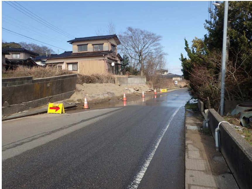
13 県道沿いの被害
