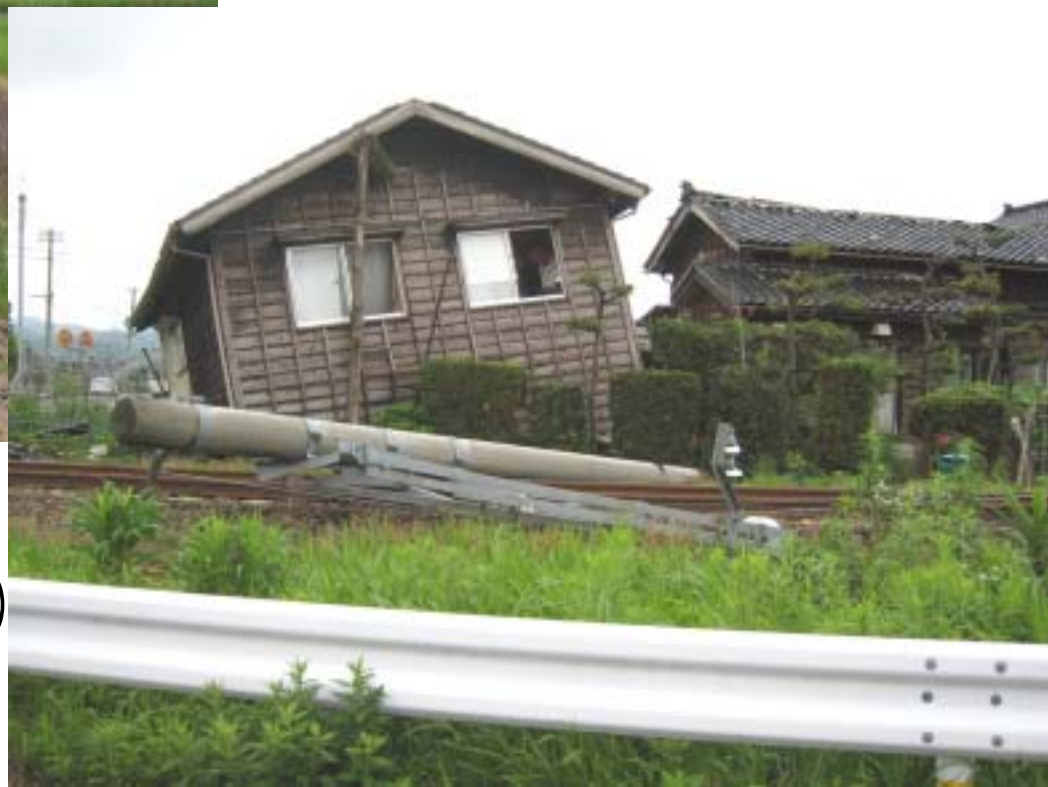
JR越後線(刈羽駅周辺) 電柱の転倒
