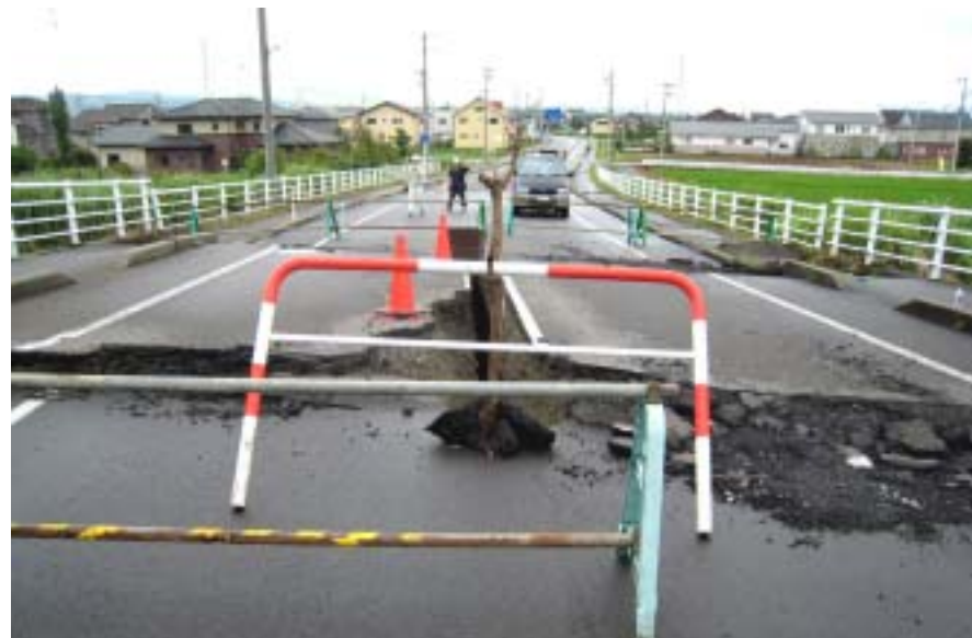
ボックスカルバートの被害
