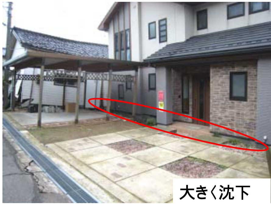
道路方向へ地盤が移動
