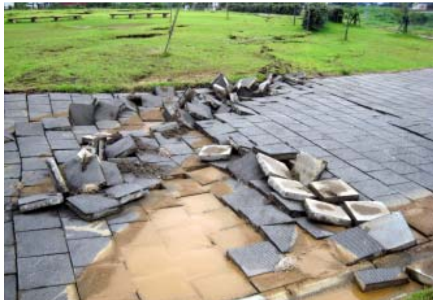
噴砂を伴いながら、河川方向に側方流動
