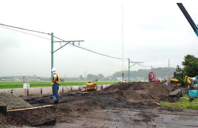
復旧中の荒浜駅
