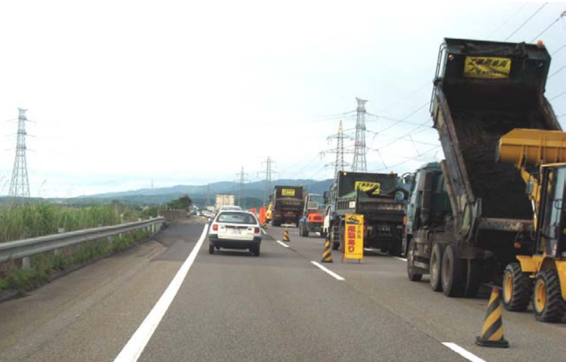
北陸自動車道柏崎付近
