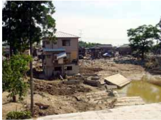
口絵 5-13 破堤箇所の堤内地側
