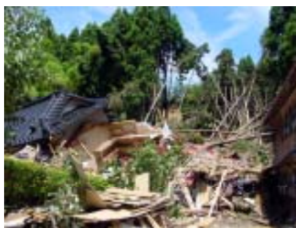
図2 中山の斜面崩壊による家屋崩壊
