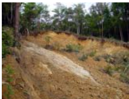
図3 中山の斜面崩壊(崩壊上部)
