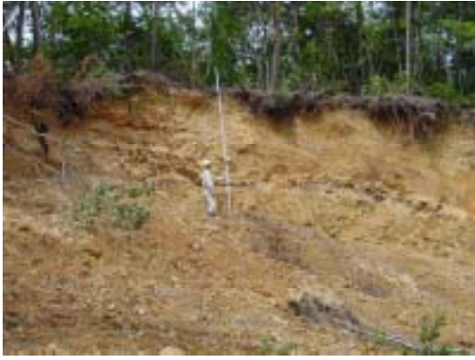
図4 中山の斜面崩壊の様子
